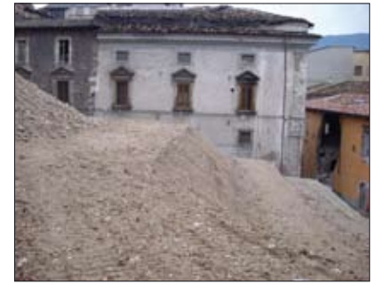
Fig. 1.11 → Riporti antropici, costituiti anche da abbondanti frammenti di laterizi, che sono serviti per il terrazzamento della corte del Palazzo Camponeschi franati con il terremoto.
