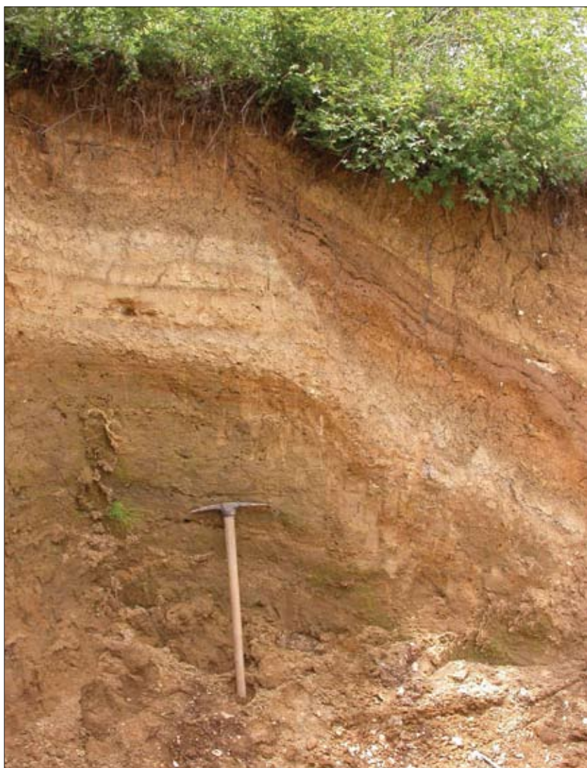
Fig. 6.12 → Alternanze di limi, limi argillosi e limi sabbiosi, addensati, sia massivi sia laminati, nettamente dislocati da un piano di faglia, che appare suturato dai colluvi più recenti.
