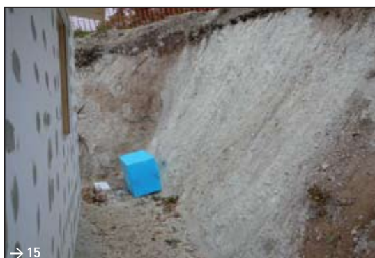
Foto 13 → Affioramento di calcari estremamente fratturati nei pressi del centro abitato. L'elevata fratturazione non consente l'individuazione di una stratificazione certa nell'ammasso roccioso.
