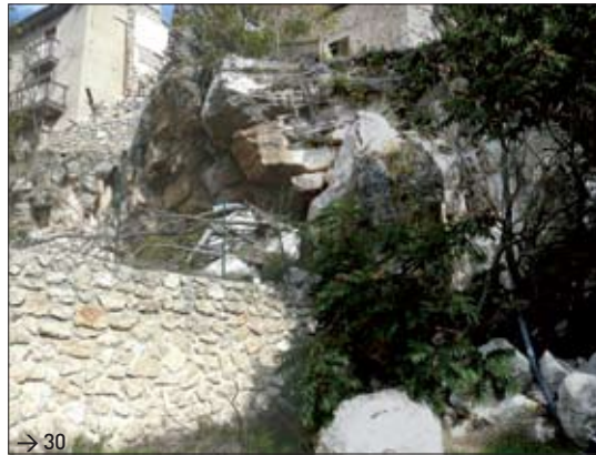
Foto 28 → Coltri eluvio-colluviali affioranti lungo gli sbanchi per la realizzazione delle case in legno.
